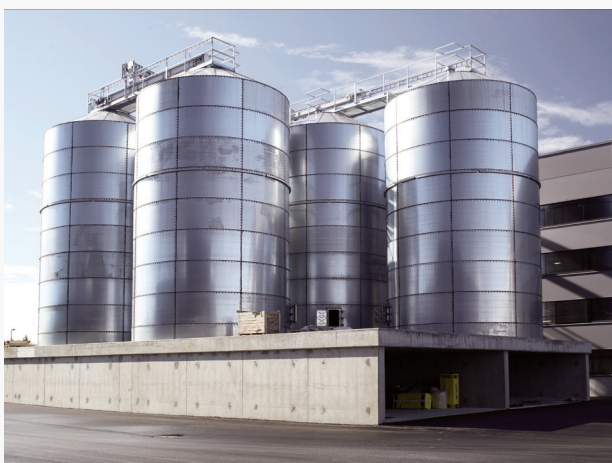
Silo de armazenamento
